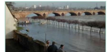
Les piles du Pont de Loire sont des obstacles pour les écoulements et une arche est même fermée.
